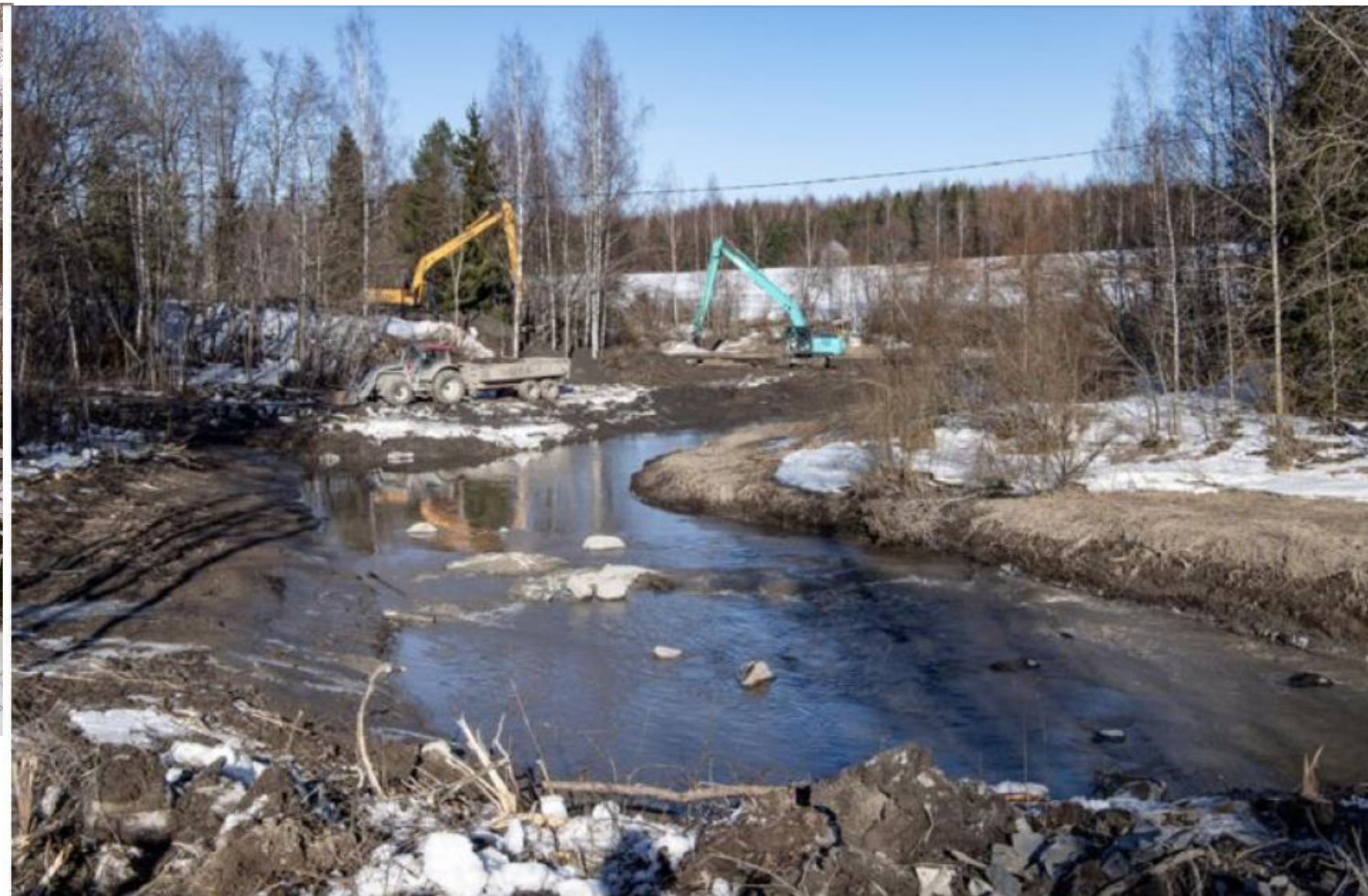
Padon osittaisen purun jälkeen urakoitsija Matti Hakamäki Oy:n kaivurit ruoppaavat joenpohjasta tonneittain savea, joka läjitetään lähipelloille.
