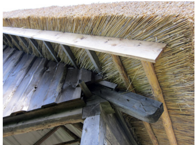
Ruokoniput kiinnitetään kukinto ylöspäin ja paksumpi tyvi alaspäin. Ruokokate on yleensä 300–350 mm paksu.
