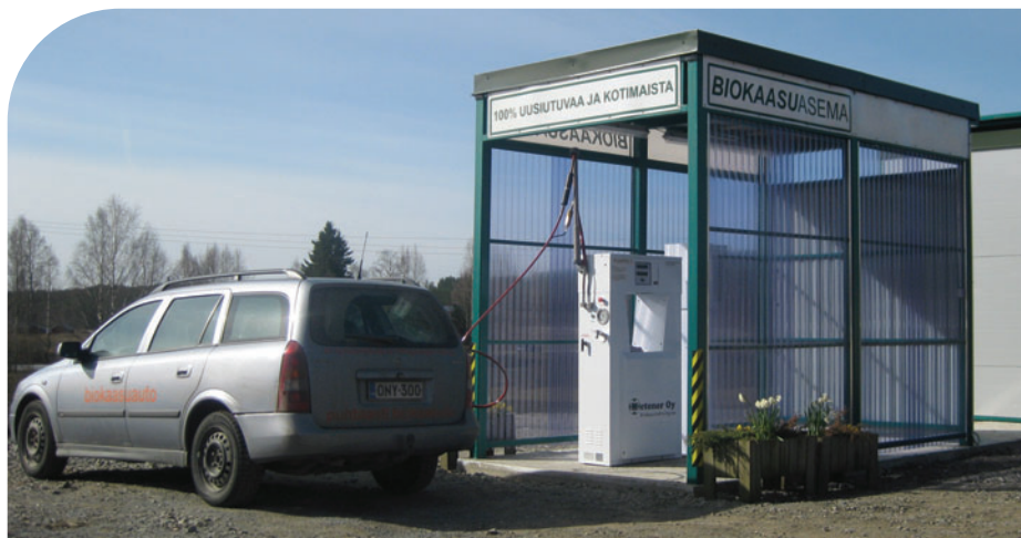
Kuva 20. Biokaasukäyttöisen auton tankkaus vuonna 2011 rakennetulla biokaasuasemalla Erkki Kalmarin tilalla Laukaassa.
