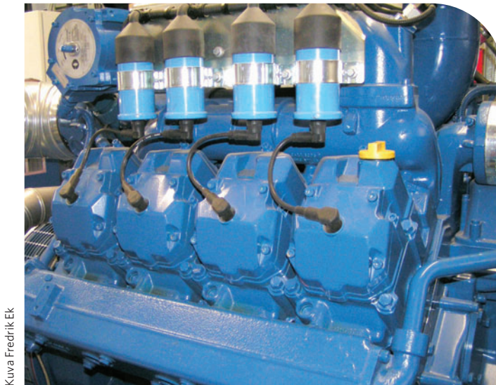
Kuva 18. Suurempi biokaasulaitos käyttää useimmiten sähköntuotannossa ottomoottoireita.
