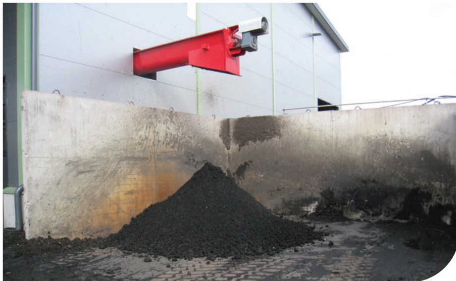
Kuva 12. Mädätysjätteiden erottelua kiinteään ja nestemäiseen osaan Envor Biotechin biokaasulaitoksella Forssassa.
